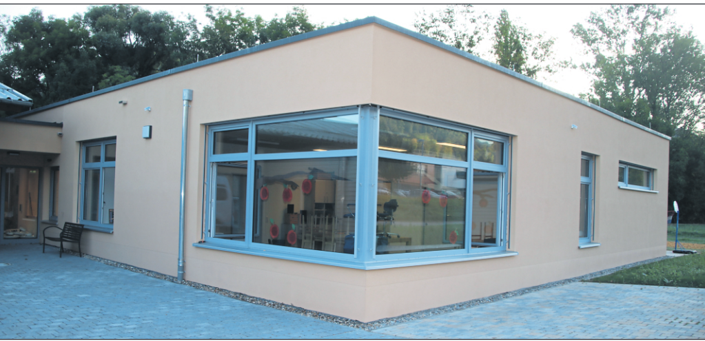
Der Neubau für die Fördergruppe Erms der Bruderhaus Diakonie.
